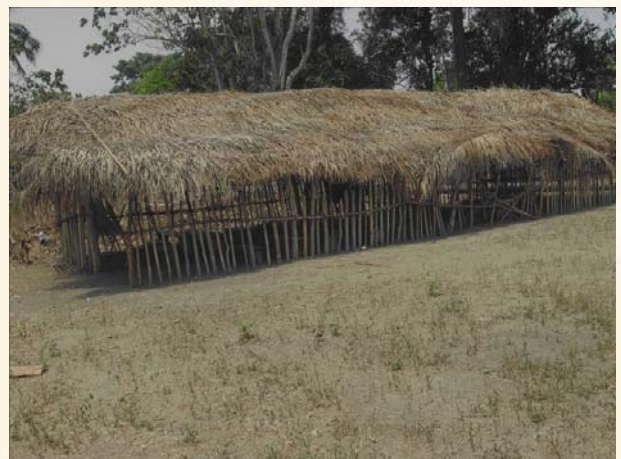
Kakutan koulu ennen Planin tuella tapahtunutta uudelleenrakentamista.
