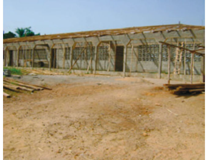
Rakenteilla oleva koulurakennus Lofassa.
